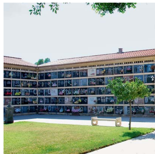
Abb. 3: Cementerio General in València (País Valenciano): Entlüftungs-Kamine auf den Firsten der hausartigen.
